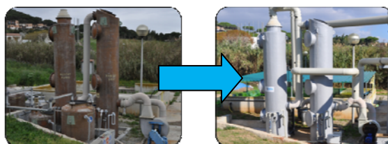
Conversión de dos lavadores químicos
